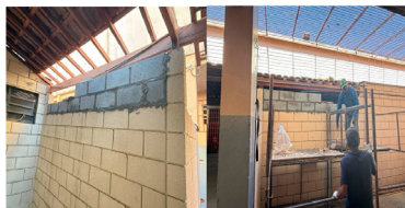
FOTOGRAFIAS DURANTE AS OBRAS
