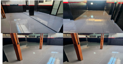
FOTOGRAFIAS APÓS CONCLUSÃO DAS OBRAS
