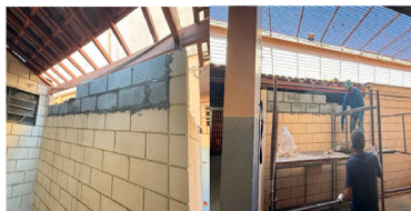
FOTOGRAFIAS DURANTE AS OBRAS
